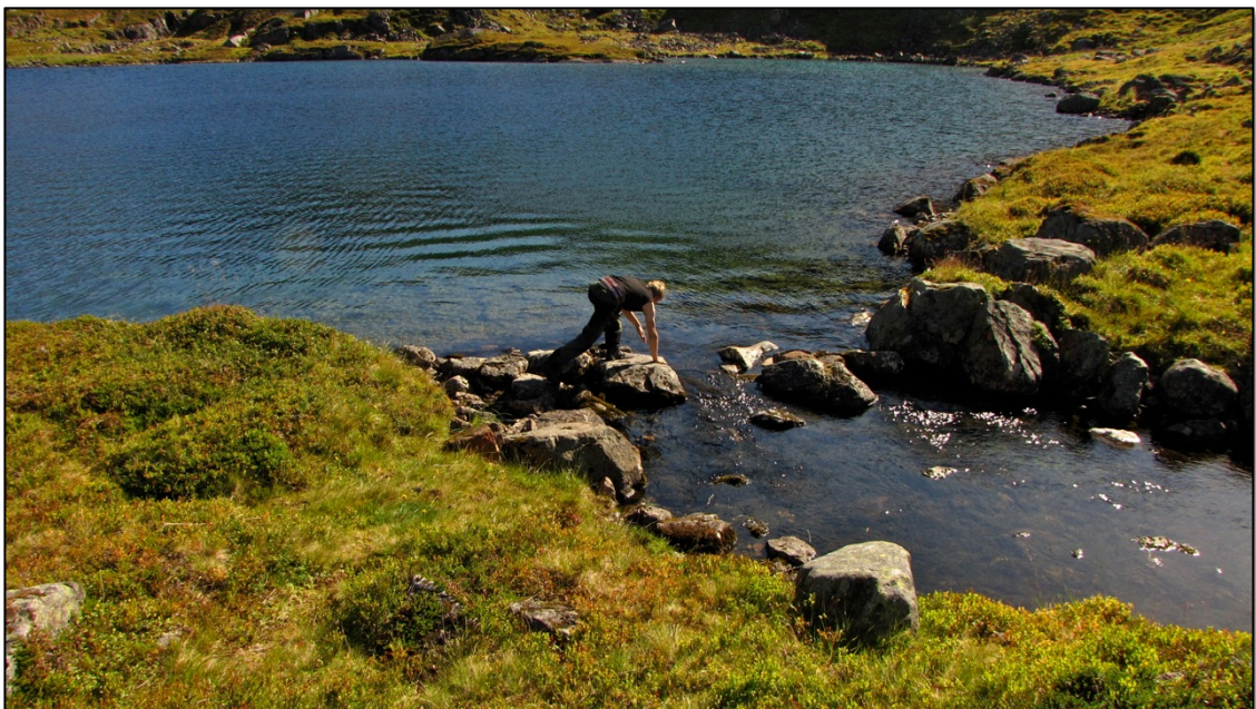
Figur 3. Hamnelva rundt inntaksområdet. Vannet i bakgrunnen vil bli demmet opp og fungere som magasin. Foto: Geir Arnesen.
